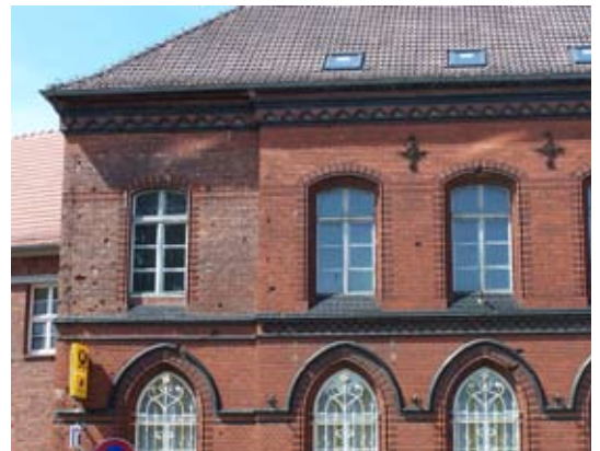
Gebäude vor der Sanierung
