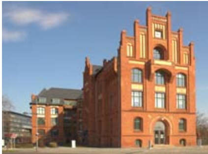
Umbau der ehemaligen Borsig-Hauptverwaltung zu einem Geschäfts- und Ärztehaus in Berlin-Tegel
